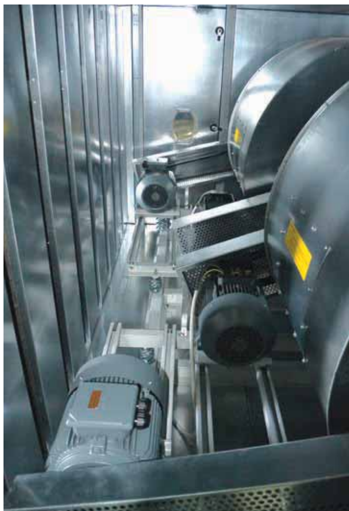
Dual fan and run & standby motor
